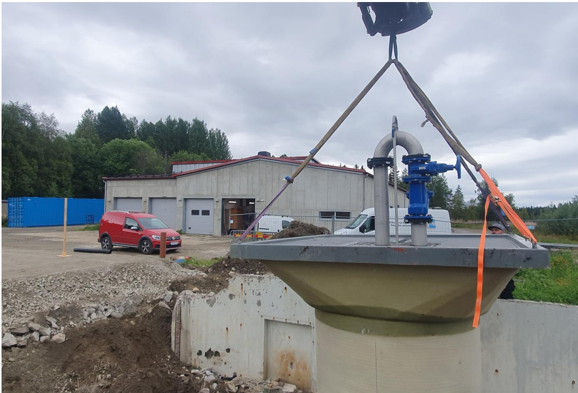
Figur 28, Installation av pumpstation
