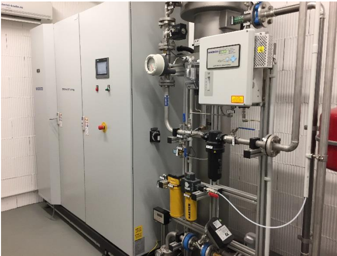
Figur 16. Exempel på en ozongenerator.
