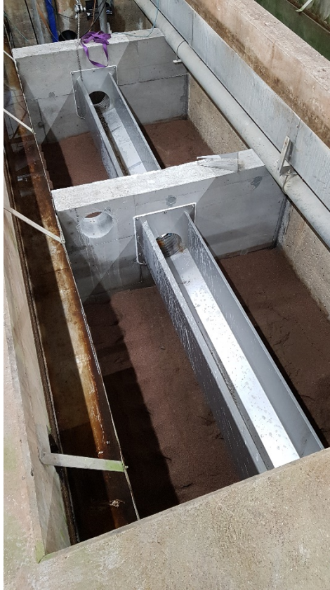
Invändiga sandfilter direkt efter fyllning.
