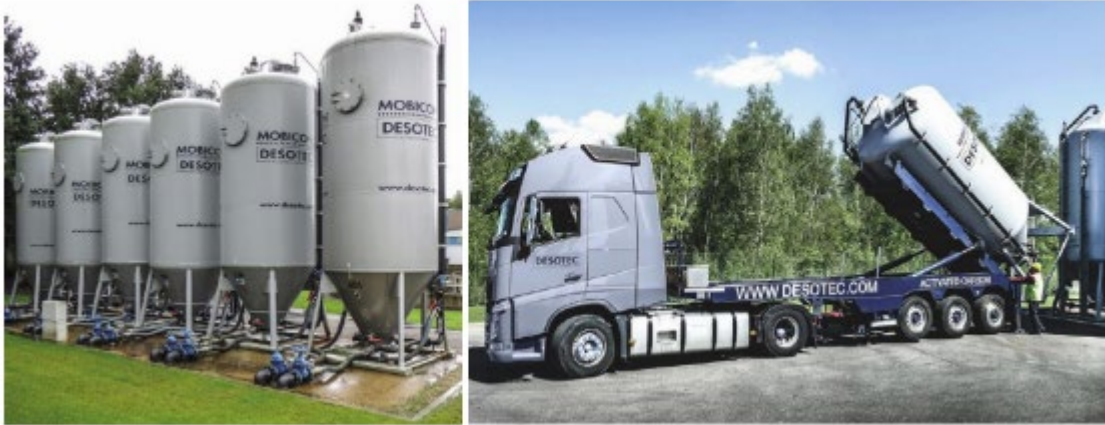
Figur 1. Modulbaserad filterlösning där tankar levereras komplett med kol. För detta system behövs minimal infrastruktur på reningsverket och dimensioneringen kan utvidgas vid behov. Från Baresel et al. (2021).
