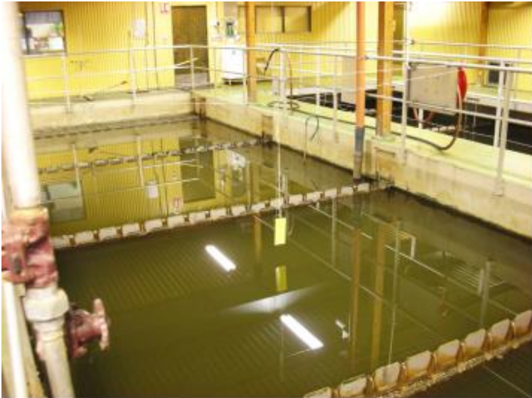
Bild 3 Slutsedimentering med fångstplatta på en ARV i Lekeberg Kommun (Bild, Leif Sildén )
