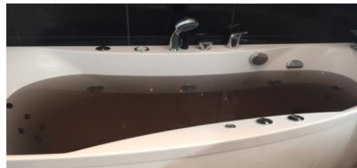
Mangan i ledningar
