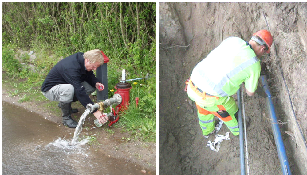
Figur 4.4: Prøvetagning fra brandhane og udkæring af rørstykke
