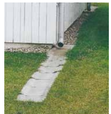
Exempel på lokalt omhändertagande av dagvatten, LOD, på privat mark.
